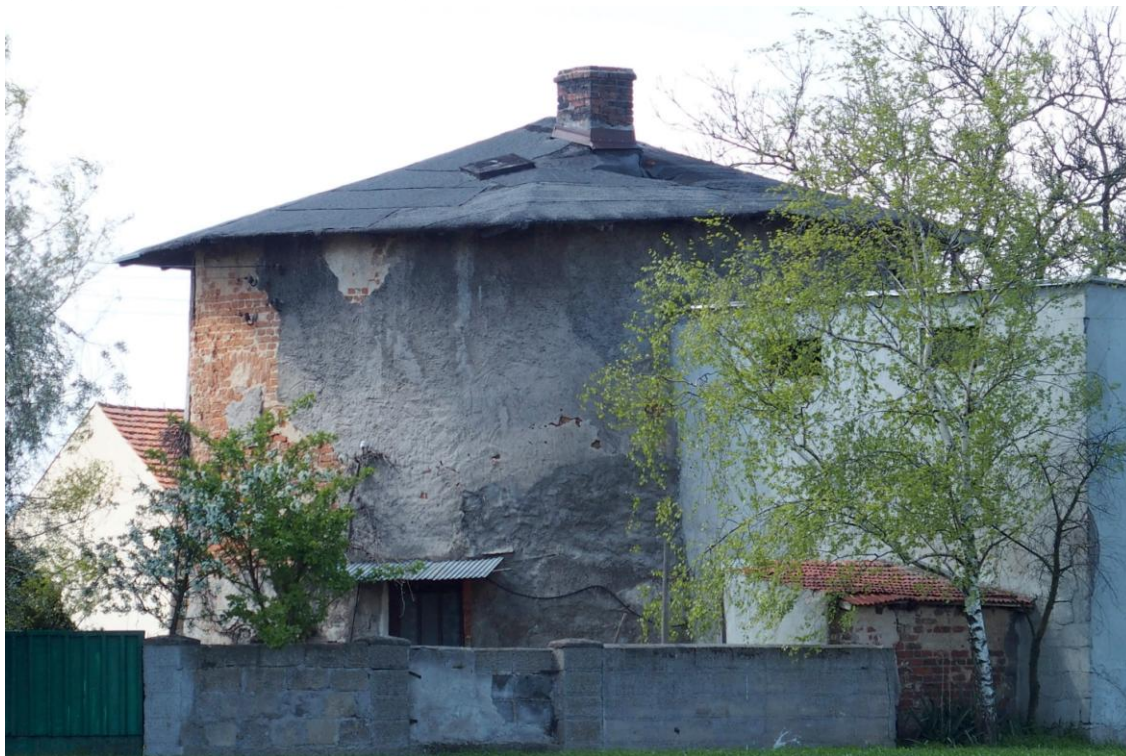
Widok budynku od wschodu
