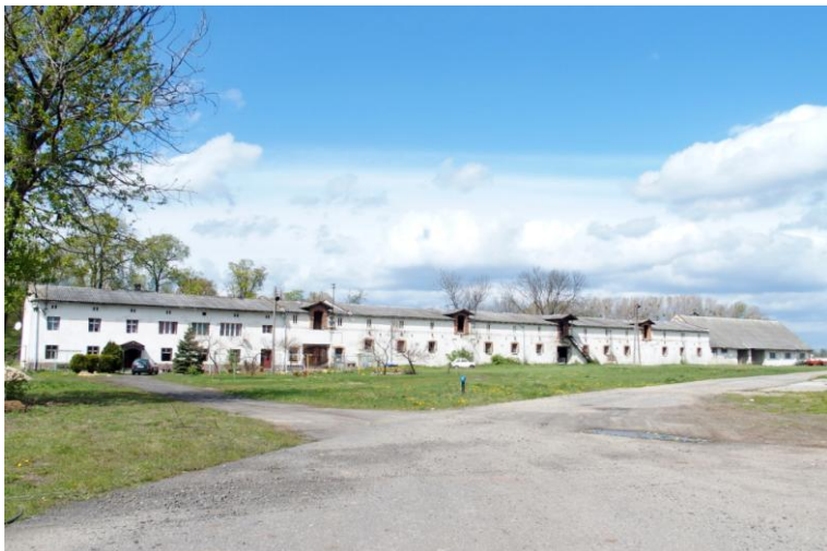
Bud. mieszkalno-gospodarczy, widok budynku od południowego-wschodu
