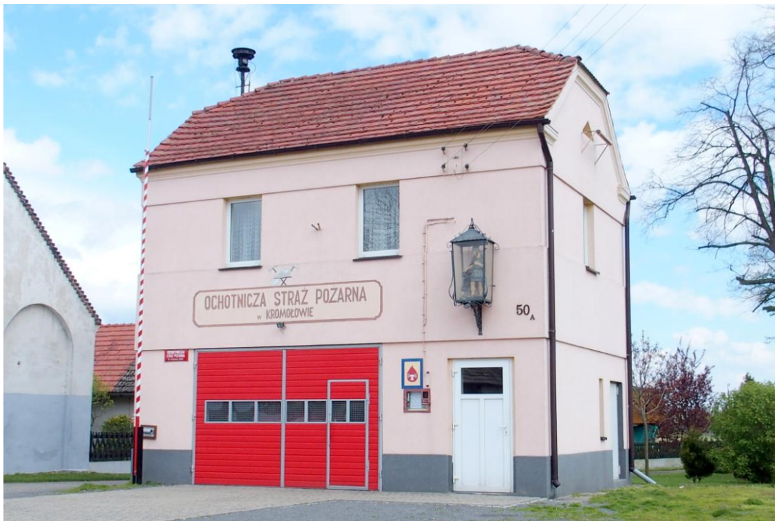
Widok budynku od południowego-zachodu
