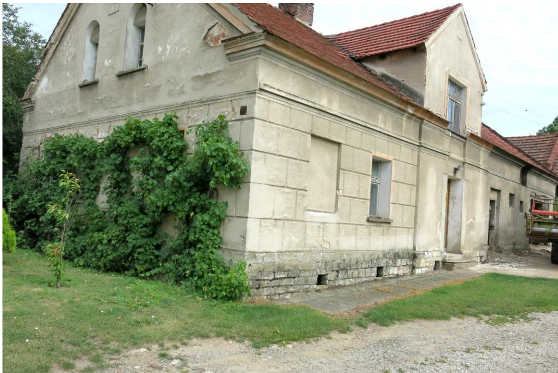
Widok budynku od południowego-wschodu
