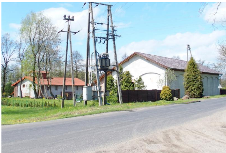
Widok od południowego-wschodu
