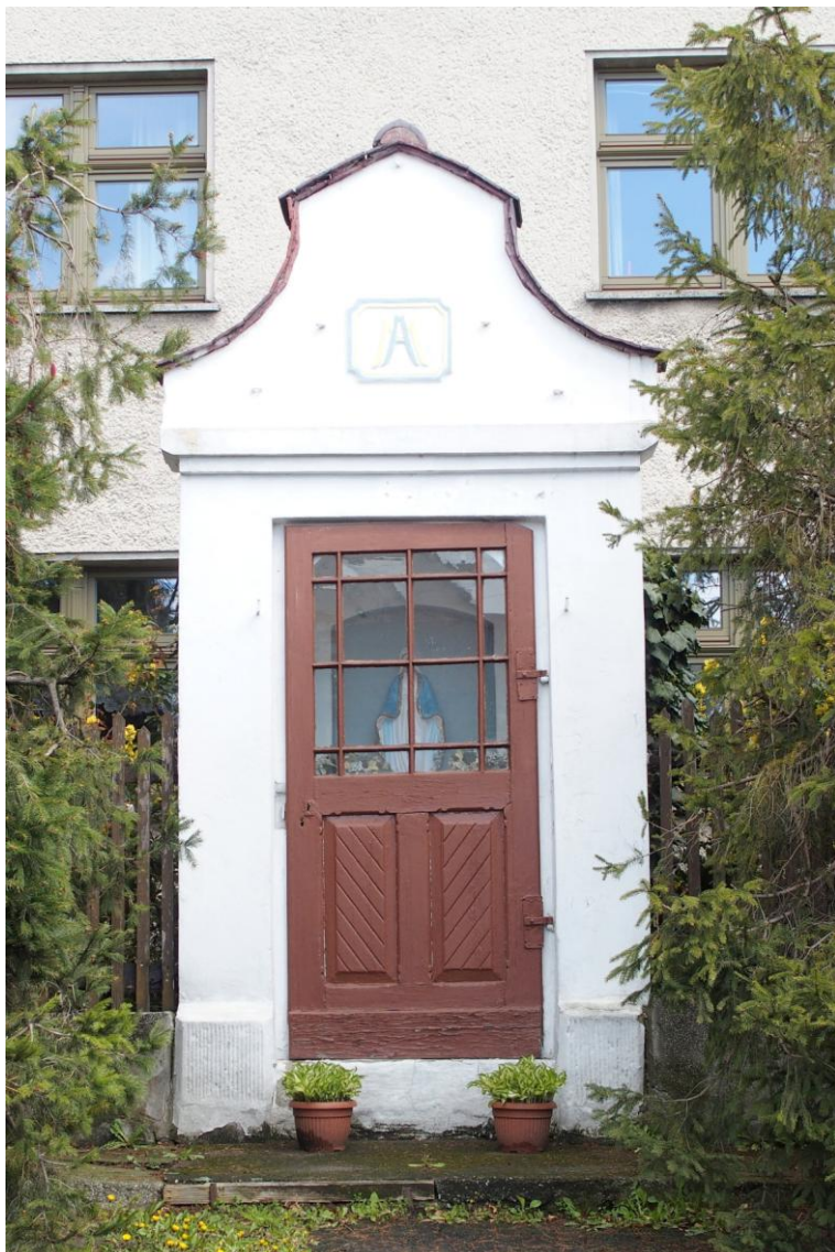
Widok od południowego-zachodu
